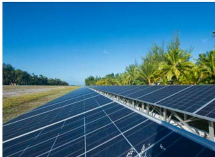
L'[énergie solaire](#) produite par les 4000 panneaux photovoltaïques implantés le long de la piste d'atterrissage couvre 75% des besoins énergétiques du resort. Ces panneaux prouvent qu'un espace non utilisé peut devenir productif. Les [chauffe-eaux solaires](#), quant à eux, alimentent la quasi-totalité des besoins en eau chaude de l'hôtel.
